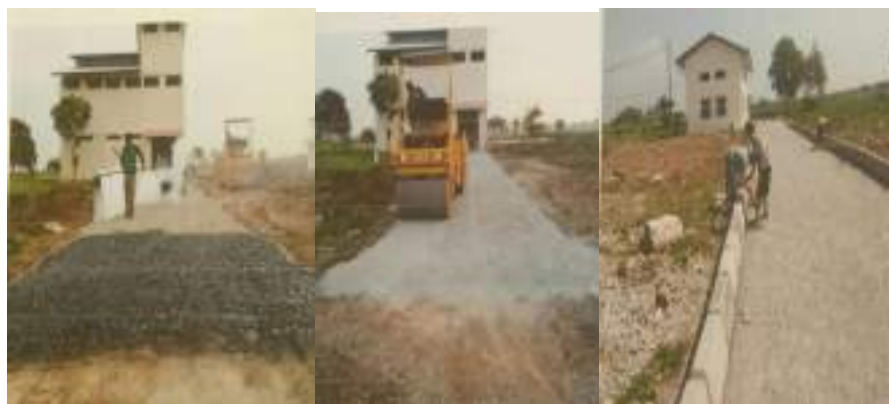
Gambar 16. Pengerasan jalan konektor antar gedung dan jalan utama di lokasi TSP
