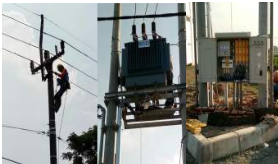
Gambar 15. Pemasangan jaringan listrik di lokasi TSP
